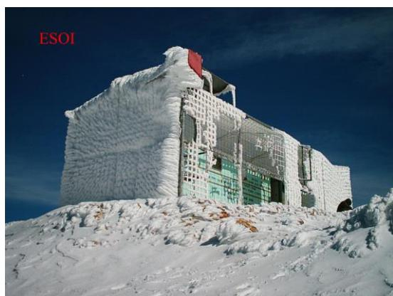
Рис.2 Накопление снега на поверхностях клетки Фаадея, которой для грозовой защиты окружена станция ESOI.
